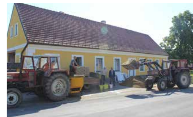
Große Baustelle in der ehemaligen Volksschule in Rappolz
